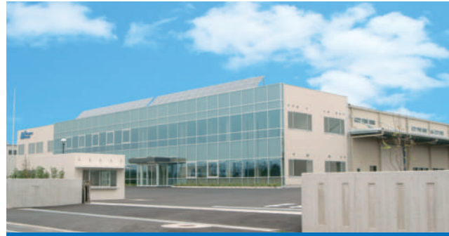
千葉工場 ISO 9001:2015認証取得 環境に配慮した“エコ工場”
