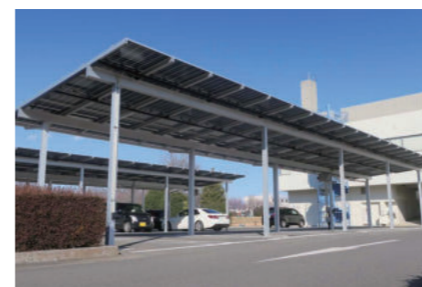
茨城県つくば市 研究施設駐車場 駐車台数：20台 DC容量：57kw
