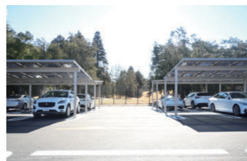
千葉県大多喜町ゴルフクラブ 駐車台数：166台 DC容量：513.93kw
