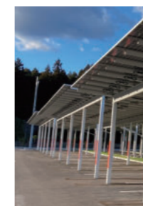
GL 不陸調整による段違い設置例
