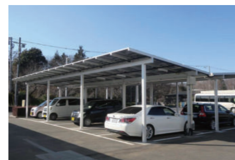
茨城県龍ケ崎市 従業員駐車場 駐車台数：20台 DC容量：57kw
