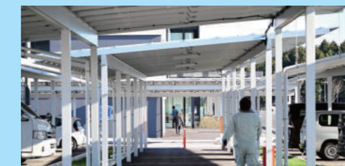
建屋までの歩道（グリーンベルト）への設置例 利用者の方が雨に濡れにくく、通常時発電を確保しながら利便性の向上を同時に訴求
