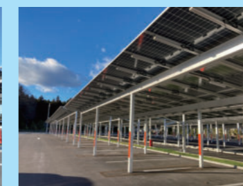
建屋までの歩道（グリーンベルト）への設置例 利用者の方が雨に濡れにくく、通常時発電を確保しながら利便性の向上を同時に訴求
