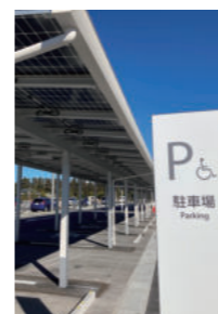
幅広の駐車場にも対応可能
