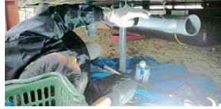
床下配管作業に
