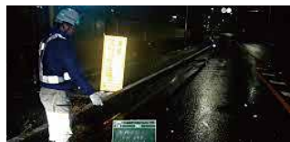
夜間土木作業
