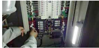
分電盤工事に
