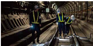
夜間トンネル工事
